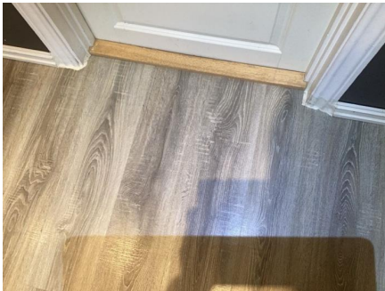
Laminat i stue utenfor soverom kan presses litt ned.
