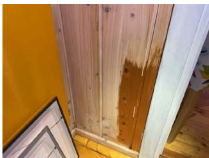
Gjenstår tiltak på enkelte overflater der oppussing bør foretas, da det er stedvis påbegynt og med ufagmessighet
