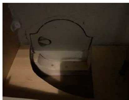
Sotluke er plassert i skap på kjøkken
