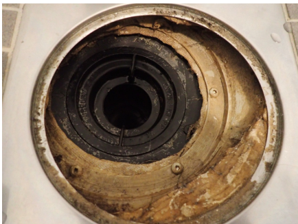
Klemring og tettesjikt i sluk
