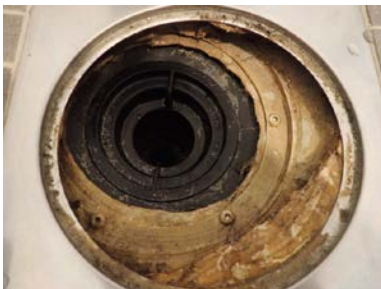
Klemring og tettesjikt i sluk
