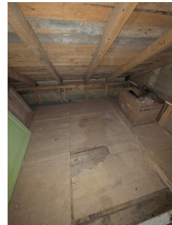
Oversikt mot gammel loddpipeline som er tatt ned under taktekingen og den står igjen på loftet. Bør fjernes. Synlige fuktmerker i takkonstruksjon.
