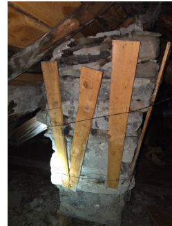
Oversikt mot gammel loddpipeline som er tatt ned under taktekingen og den står igjen på loftet. Bør fjernes. Synlige fuktmerker i takkonstruksjon.
