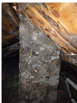
Sprekker i pipeløp og saltutslag i pipe sett fra kryploth
