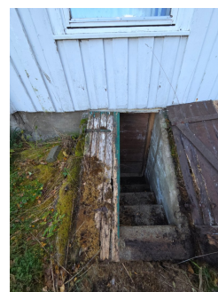
Dør til kjeller med luke over nedgang
