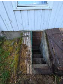
Dør til kjeller med luke over nedgang
