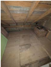
Oversikt mot gammel loddpipe som er tatt ned under taktekingen og den står igjen på loftet. Bør fjernes. Synlige fuktmerker i takkonstruksjon.
