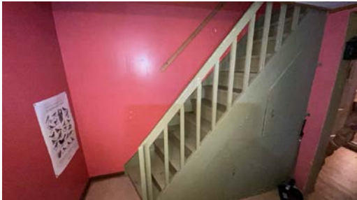
Trapp sett fra 1. etasje
