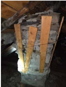
Oversikt mot gammel loddpipe som er tatt ned under taktekingen og den står igjen på loftet. Bør fjernes. Synlige fuktmerker i takkonstruksjon.
