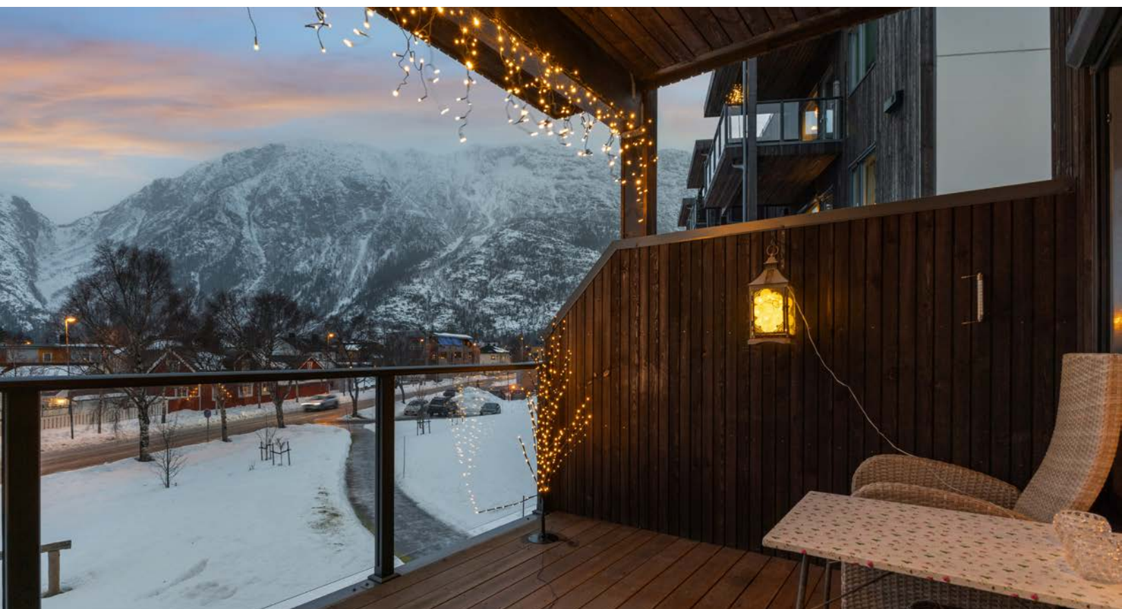
Altan på ca. 11 m 2 med rekkverk av glass og metall gir utsikt mot fjellandskapet. Rekkverkshøyden er oppgitt til å være 99 cm, noe som bør justeres for å møte dagens krav.
