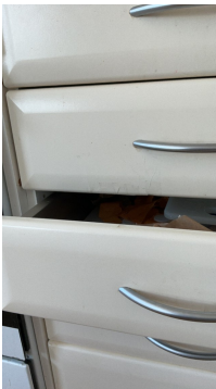
Svellet benkeplate ved vask og vaskemaskin
