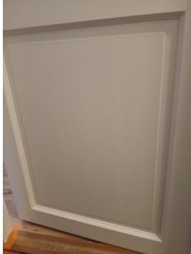
Bilde tilsendt fra huseier etter maling.
