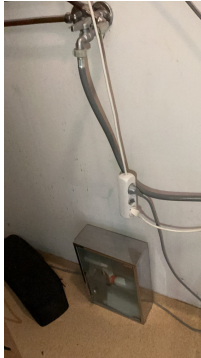
Varmtvannsbereder tilkoblet via skjøteledning
