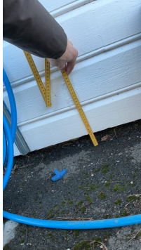
Kledning nær asfalt ved inngang.
