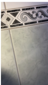
Riss i flis på yttervegg under vindu.
