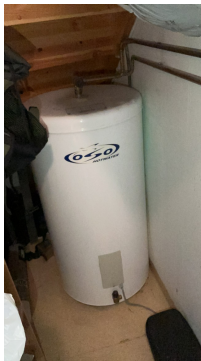
Varmtvannsbereder tilkoblet via skjøteledning
