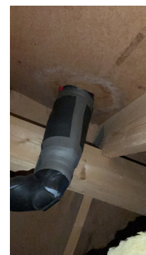
Skjolder på undertak ved gjennomføring
