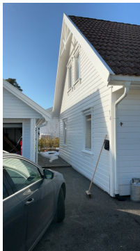
Kledning nær asfalt ved inngang.
