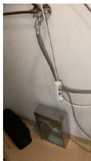
Varmtvannsbereder tilkoblet via skjøteledning
