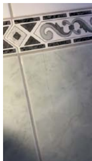
Riss i flis på yttervegg under vindu.
