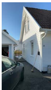
Kledning nær asfalt ved inngang.
