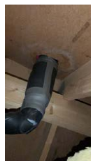
Skjolder på undertak ved gjennomføring
