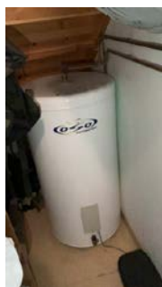
Varmtvannsbereder tilkoblet via skjøteledning
