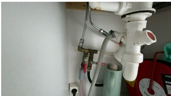
Del av rør til vann.
