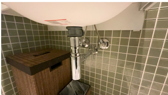
Del av rør til avløp.
