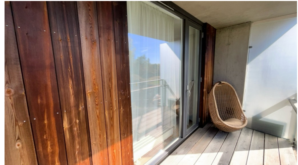
Eksempel på vindu i yttervegg.
