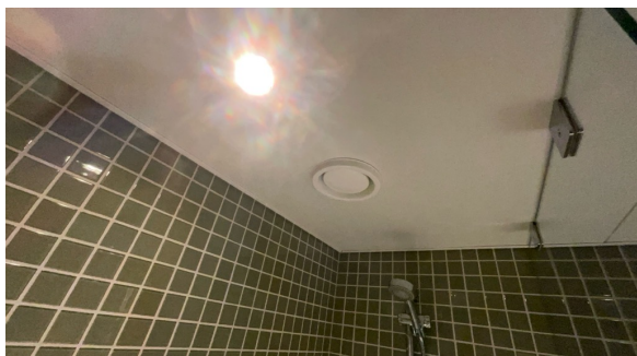
Montert avtrekk i tak.
