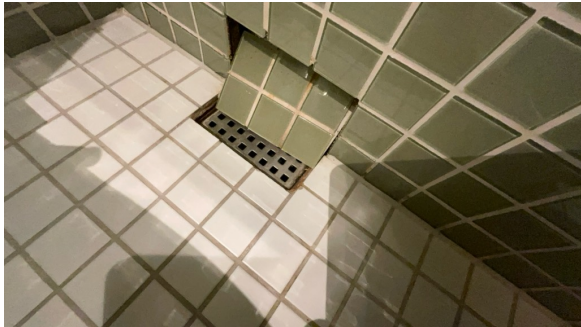
Sluk i gulv.
