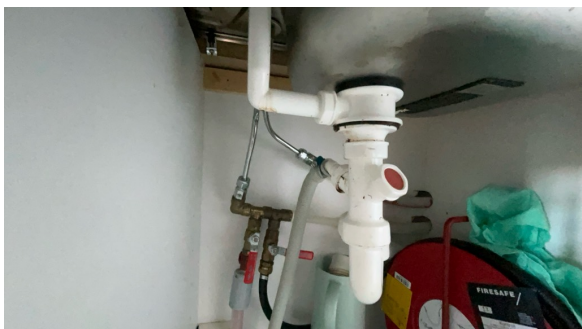
Del av rør til avløp.
