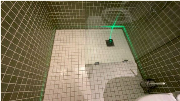
Målt fall på gulv. Del av gulv.
