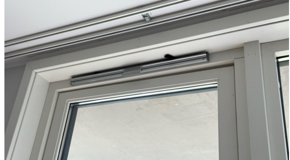
Eksempel på montert ventil i vindu.
