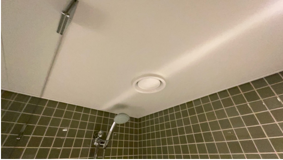
Montert avtrekk i tak.
