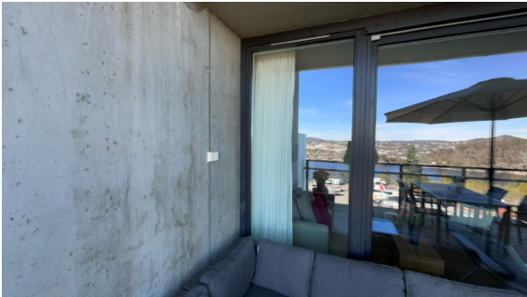
Eksempel på vindu i yttervegg.
