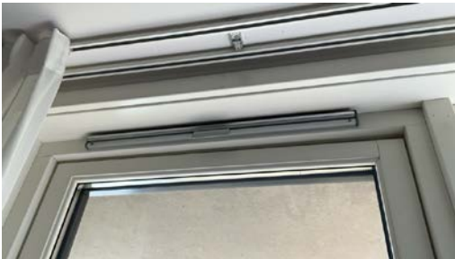
Eksempel på montert ventil i vindu.
