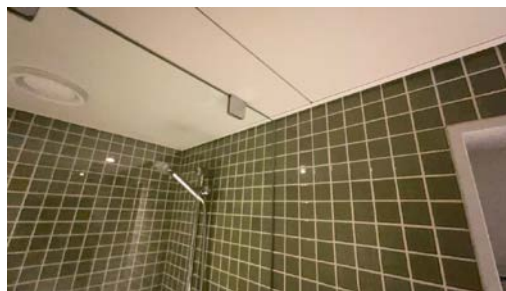
Del av vegg - tak.
