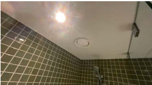
Montert avtrekk i tak.
