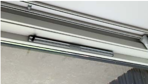
Eksempel på montert ventil i vindu.
