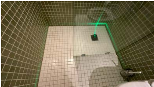
Målt fall på gulv. Del av gulv.
