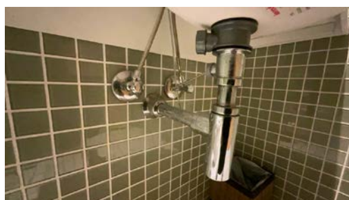
Del av rør til avløp.
