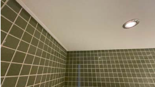
Del av vegg - tak.
