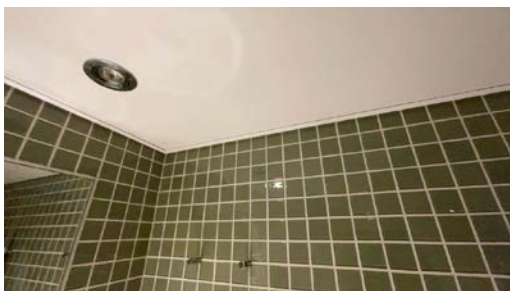
Del av vegg - tak.
