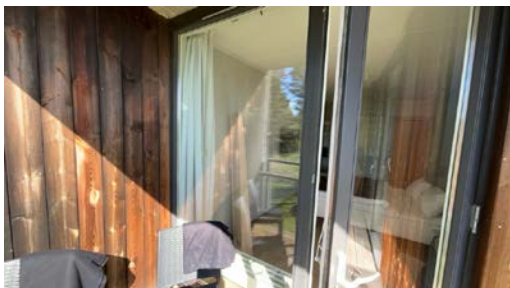
Eksempel på vindu i yttervegg.
