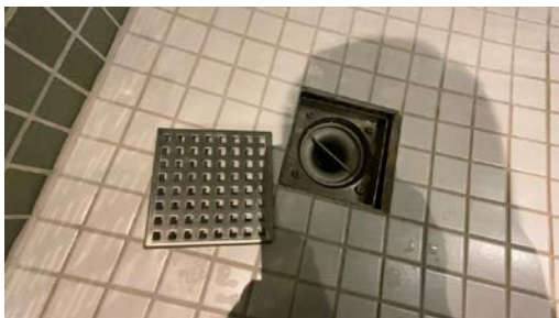
Sluk i gulv.
