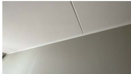
Del av vegg - tak.
