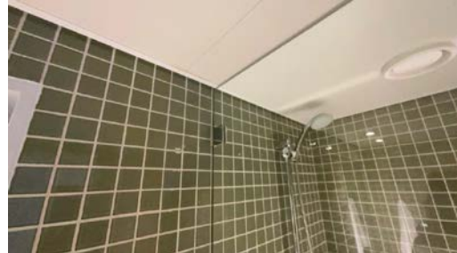
Del av vegg - tak.
