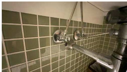
Del av rør til vann.
