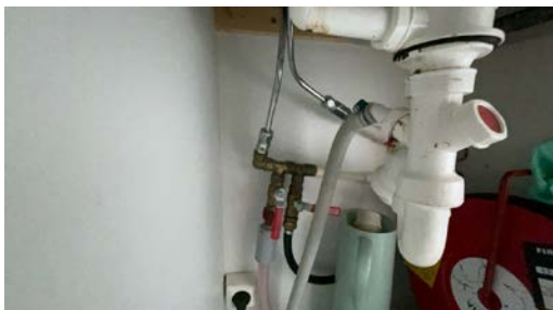
Del av rør til vann.
