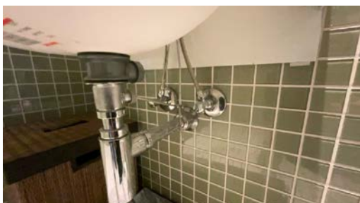
Del av rør til vann.
