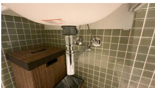
Del av rør til avløp.
