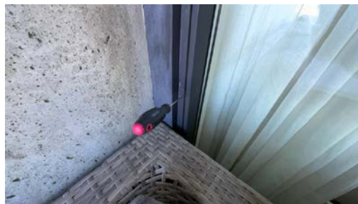
Stikk kontroll på vinduer er utført.
