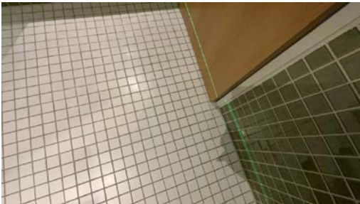
Målt fall på gulv. Del av gulv.
