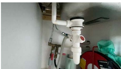
Del av rør til avløp.
