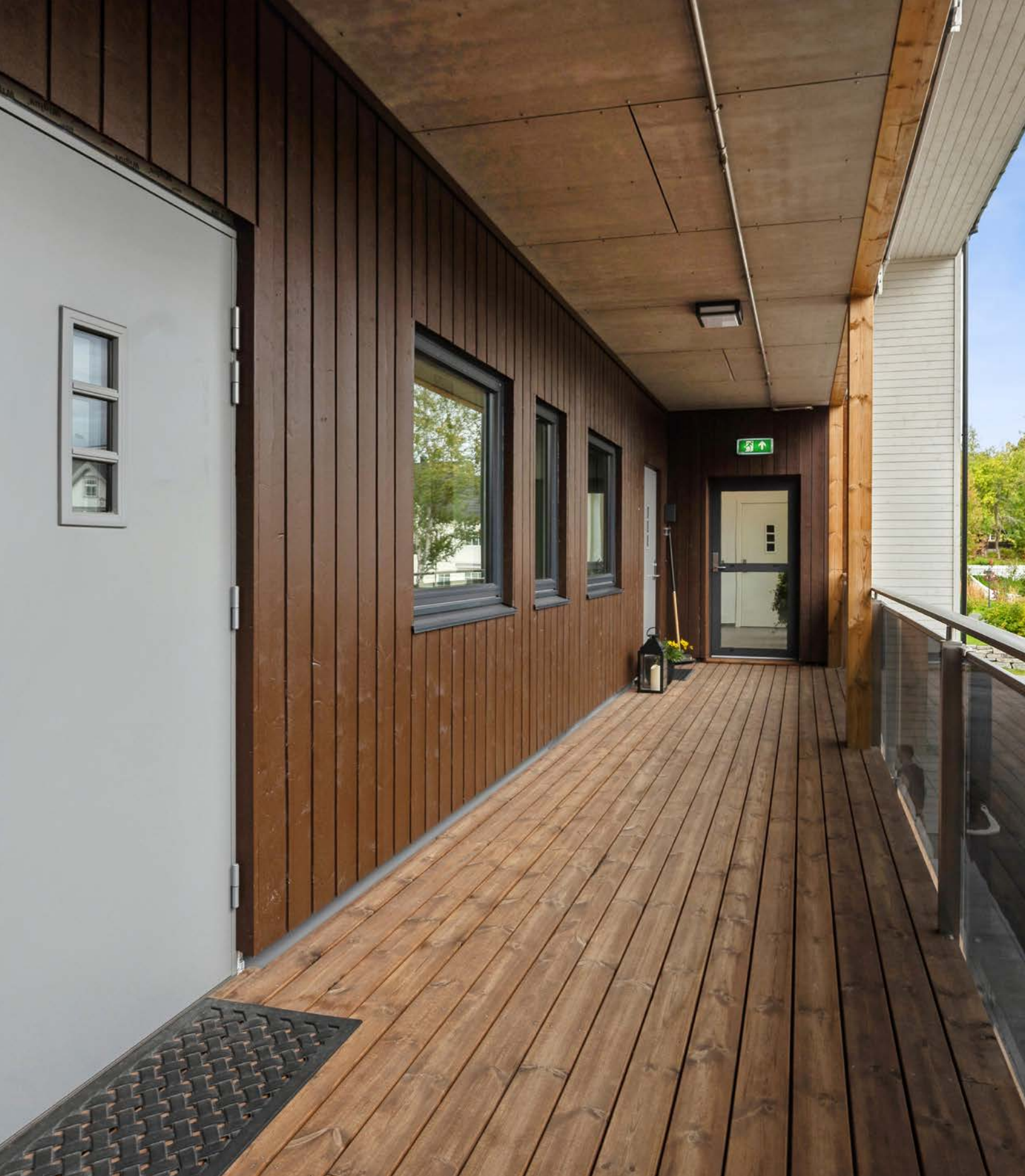
Takoverbygd svalgang med inngang til leiligheten
