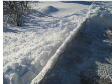
Rekkverk er ikke kommet på plass etter utvidelse.
