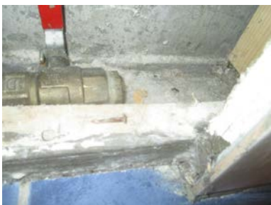
Fuktmåling i åpen vegg ved stoppekran.
