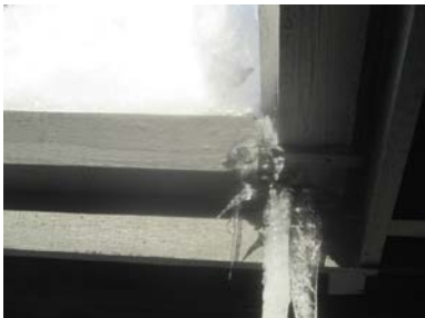
Deler av takrenner i tre.
