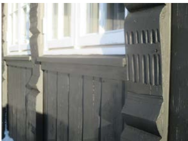
Deler av kledningen med tilhørende belistninger.
