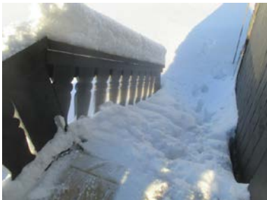
Trapp opp til terrasse på ene siden av hytta
