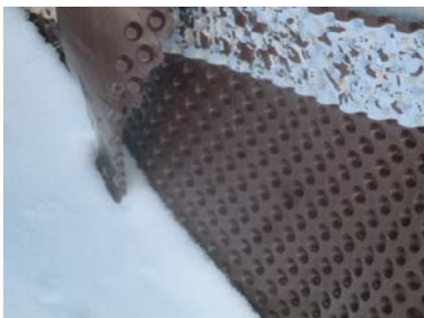
Fuktsikring i mot carport.
