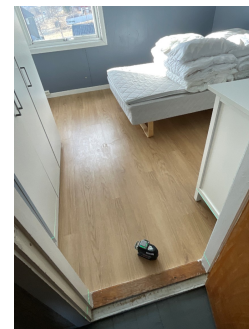
Høydemåling i soverom i 2. etasje.
