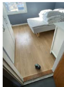
Høydemåling i soverom i 2. etasje.
