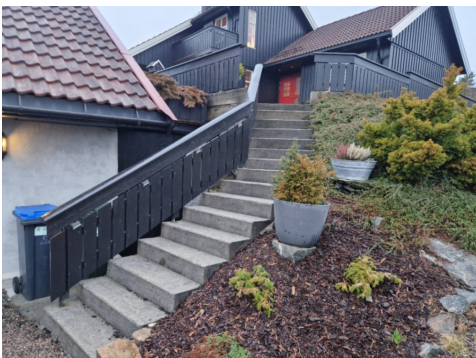
Rekkverkshøyden er målt til 87,5cm.
