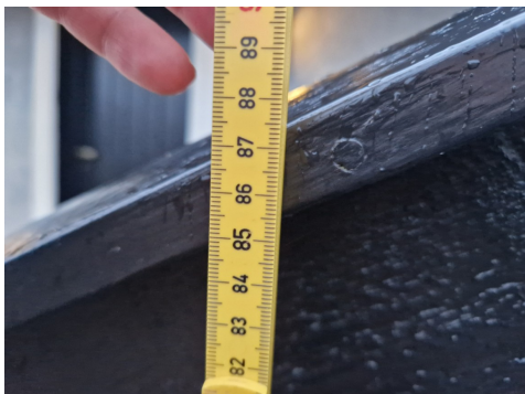
Rekkverkshøyden er målt til 87,5cm.
