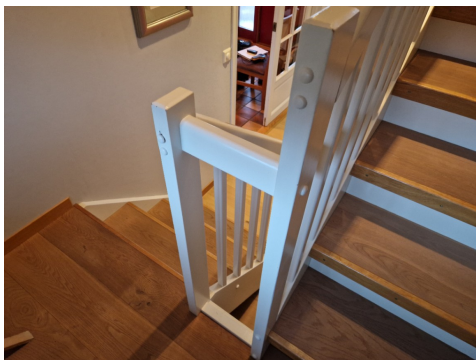
Rekkverkshøyde er målt til 87,5cm.
