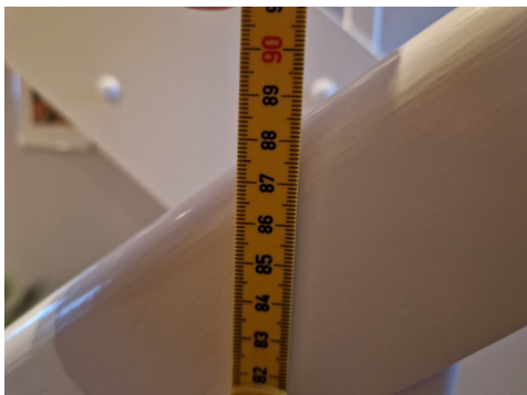
Rekkverkshøyde er målt til 87,5cm.
