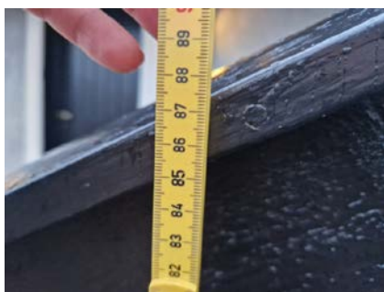
Rekkverkshøyden er målt til 87,5cm.
