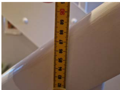
Rekkverkshøyde er målt til 87,5cm.
