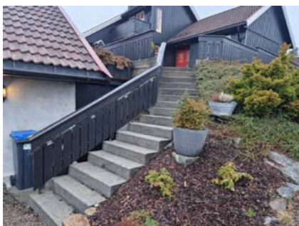
Rekkverkshøyden er målt til 87,5cm.
