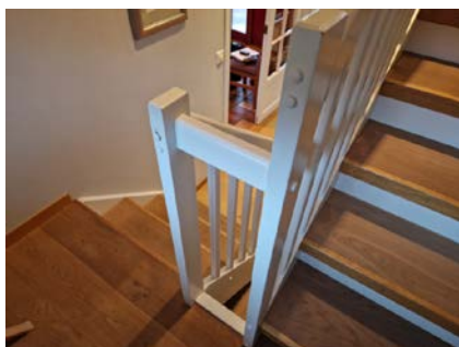
Rekkverkshøyde er målt til 87,5cm.
