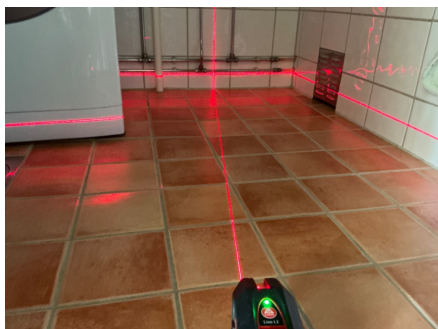
Fall på baderomsgulv er kontrollert med krysslaser.
