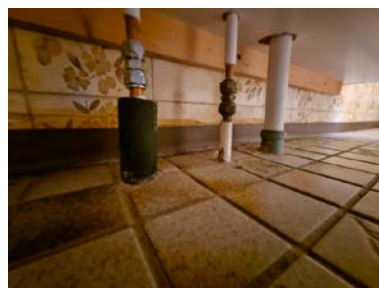
Rørgjennomføring i gulv.
