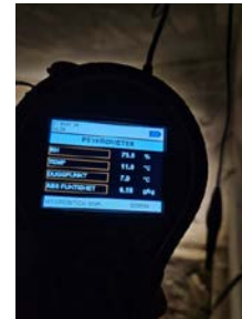
Måling av relativ luftfuktighet i krypkjeller.
