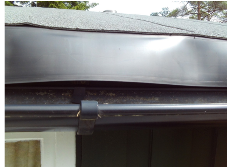
Deler av skvettzinken buler.
