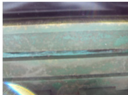
Luftespalter i gesimser.
