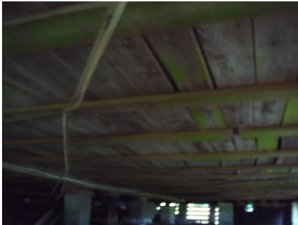
Deler av underliggende stubbloft.
