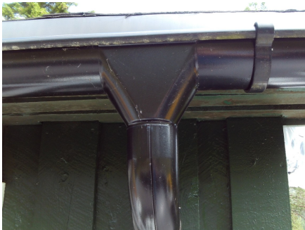
Nyere takrenner av stål
