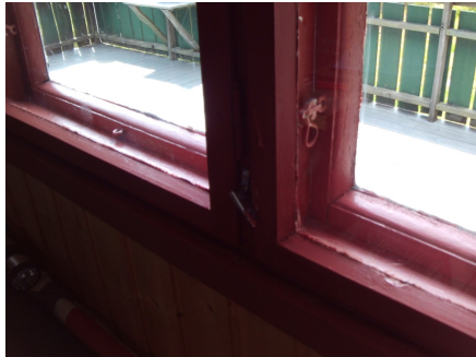
Vindu i fra innsiden med varevindu.
