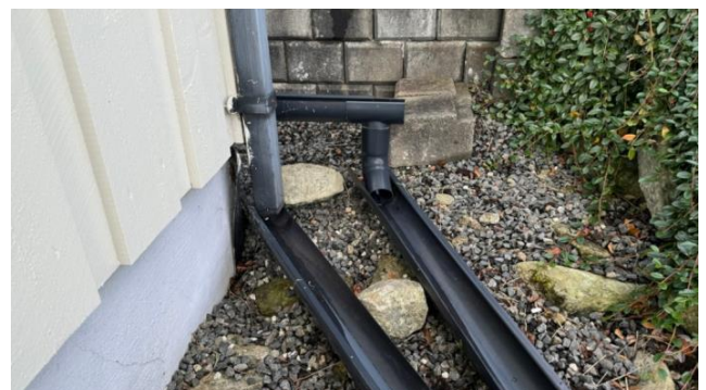
Bilde viser at deler av utførelsen på takrenne og nedløp.
