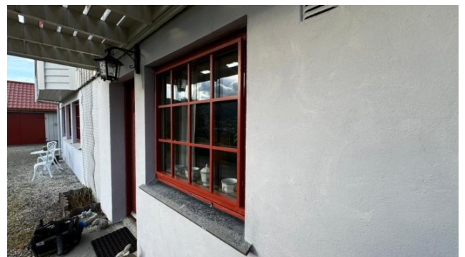
Bilde viser vindu med godt vedlikehold. Likevel tilsier alder at utskifting bør påregnes.
