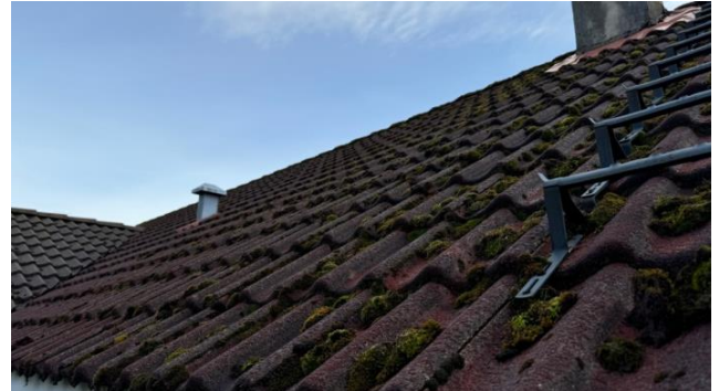
Bilde viser deler av taktekingen.
