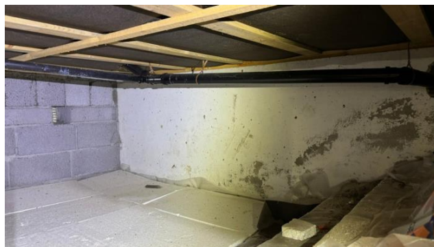
Bilde viser deler av krypkjelleren.
