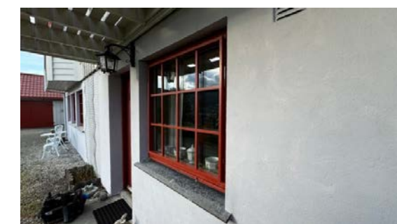
Bilde viser vindu med godt vedlikehold. Likevel tilsier alder at utskifting bør påregnes.
