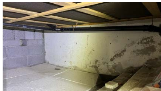
Bilde viser deler av krypkjelleren.
