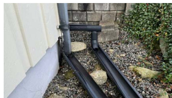
Bilde viser at deler av utførelsen på takrenne og nedløp.
