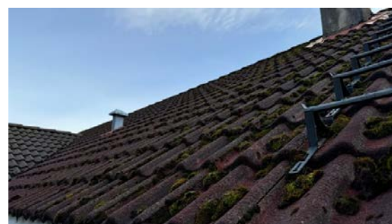
Bilde viser deler av taktekkningen.
