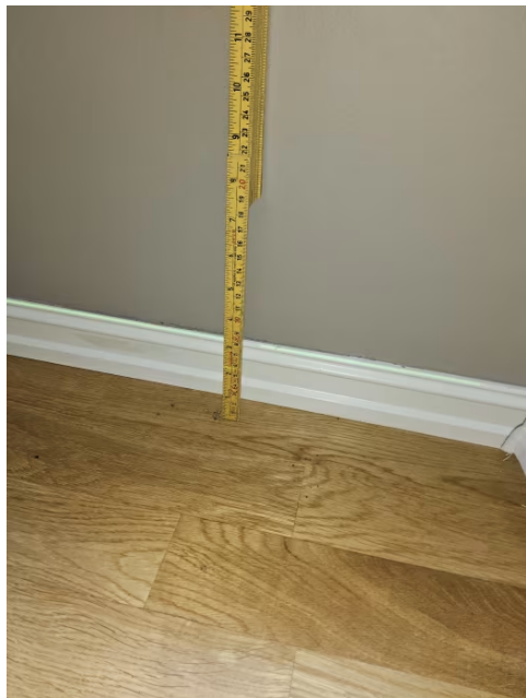
Bilde viser måling av etasjeskiller.
