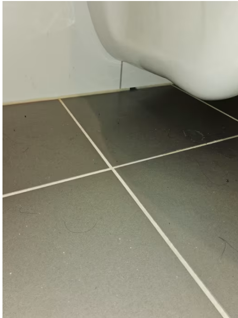
Bilde viser avrenningsspalte for innebygget systerne.
