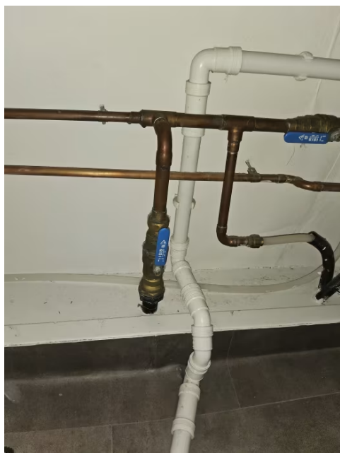
Bilde viser hovedstoppekran.
