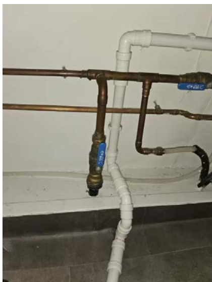
Bilde viser hovedstoppekran.
