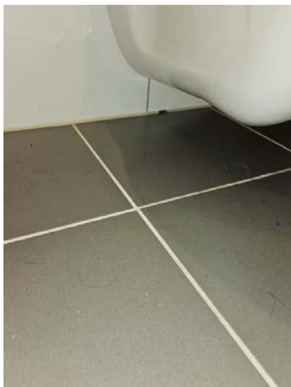
Bilde viser avrenningsspalte for innebygget systerne.
