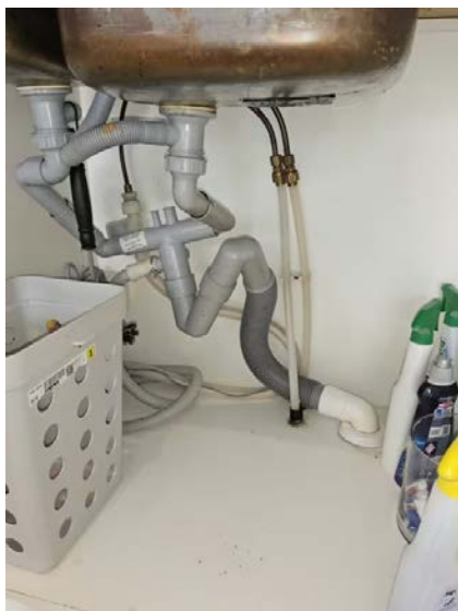
Bilde viser avløpsrør under oppvaskkum på kjøkken.
