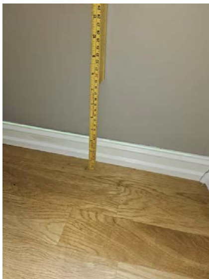
Bilde viser måling av etasjeskiller.
