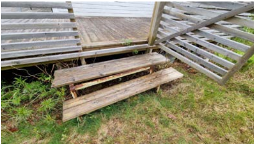
Provisorisk trapp til terrassen mot uthuset
