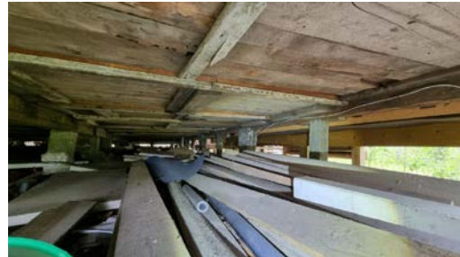
Kontroll av fundamenteringen under hytta.
