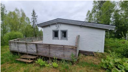
Terrassen er oppført utenfor fasade sørvest og nord vest
