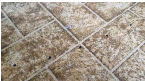
Hull/utettheter i belegget på stuen.
