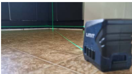
Måling av skjevheter i gulv med krysslaser.
