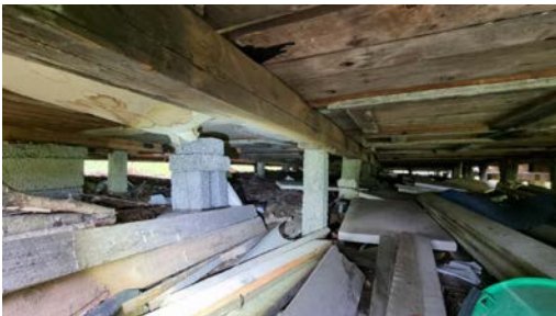
Kontroll av fundamenteringen under hytta.
