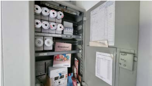
Kontroll av el-skapet.
