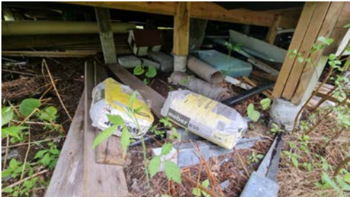
Kontroll av fundamenteringen under hytta.
