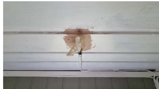
El-tilkobling via skjøteledning til belysning i himling i det ene soverommet.
