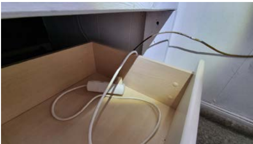
El-tilkobling via skjøteledning til belysning i himling i det ene soverommet.
