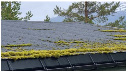
Visuell besiktelse av taket
