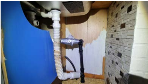
Kontroll av avløpsrør under oppvaskkummen.
