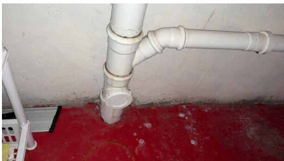
Stakepunkt i kjeller.
