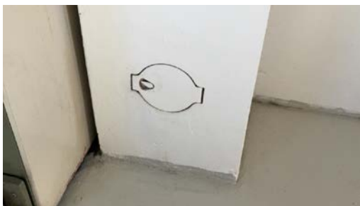
Sotluke i kjeller.
