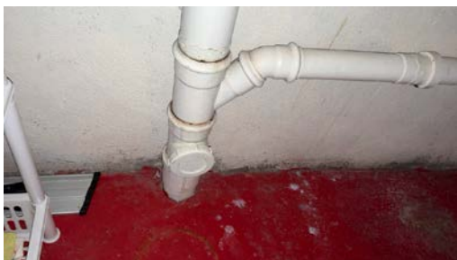
Stakepunkt i kjeller.
