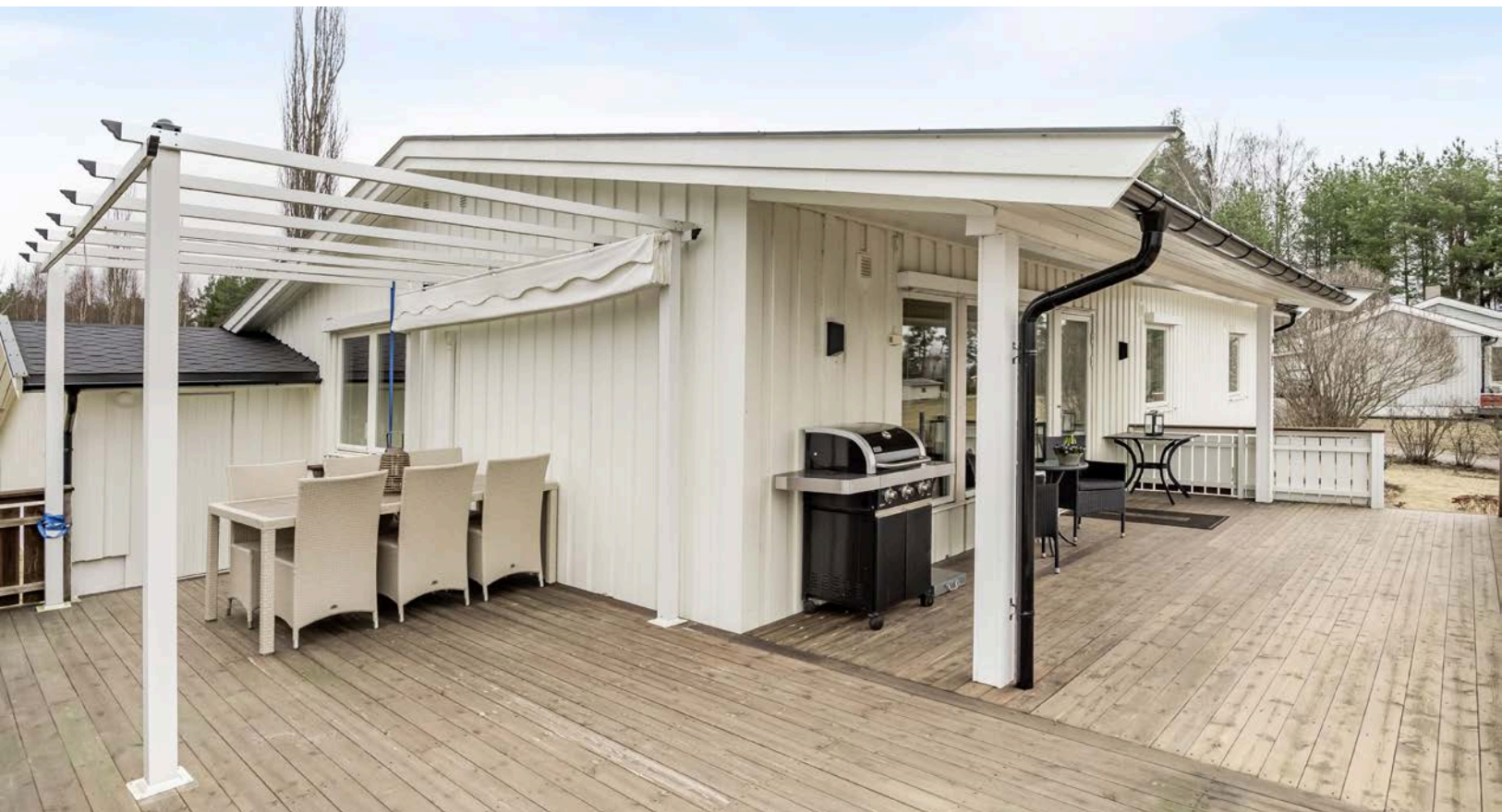
Terrassen er oppført med punktfundamentering og betongpilarer, deler med takoverbygg.
