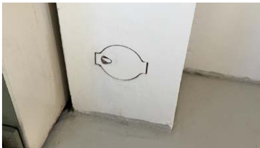
Sotluke i kjeller.
