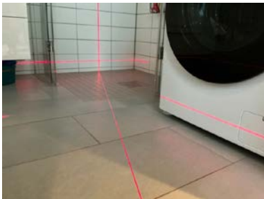
Fall på baderomsgulv er kontrollert med krysslaser.
