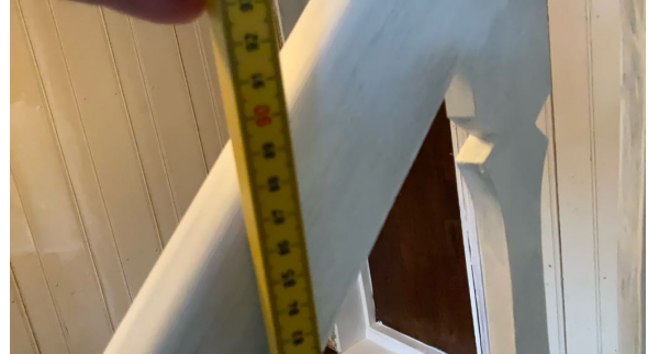
Måling av høyde på rekkverk i trapp.
