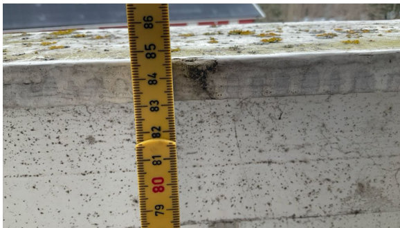
Måling av høyde på rekkverk.
