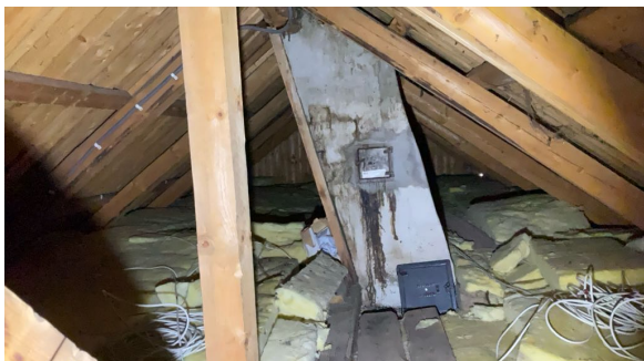
Pipe på loft.
