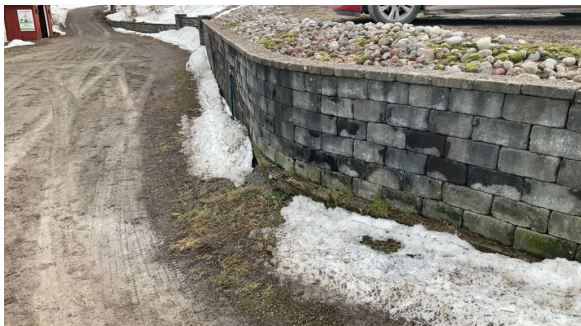
Forstøtningsmur mot gårdsplass.
