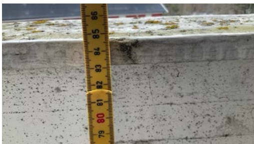
Måling av høyde på rekkverk.
