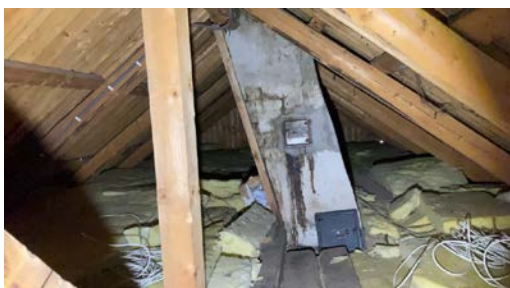
Pipe på loft.
