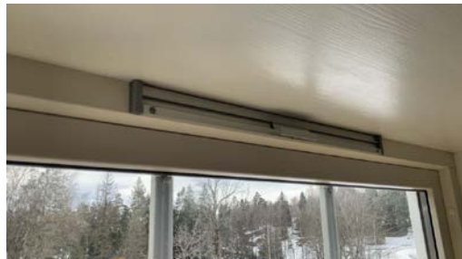
Tilluft fra ventil i vindu
