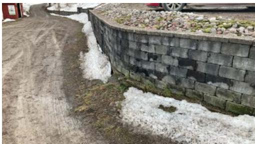
Forstøtningsmur mot gårdsplass.
