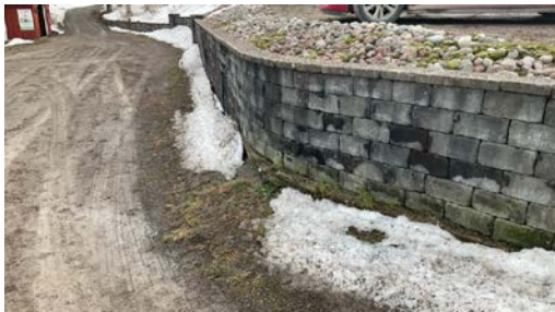
Forstøtningsmur mot gårdsplass.
