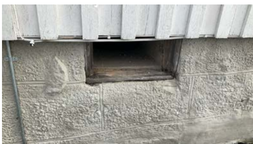
Luke inn til krypkjeller
