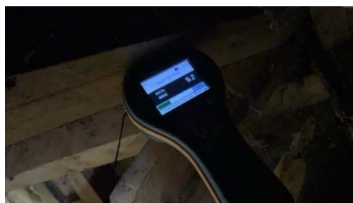
Ved fuktmåling av trekonstruksjon er det registrert måleverdier som ligger i normalområde for tørt treverk.
