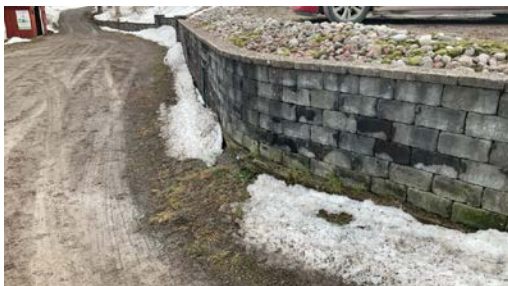
Forstøtningsmur mot gårds plass.
