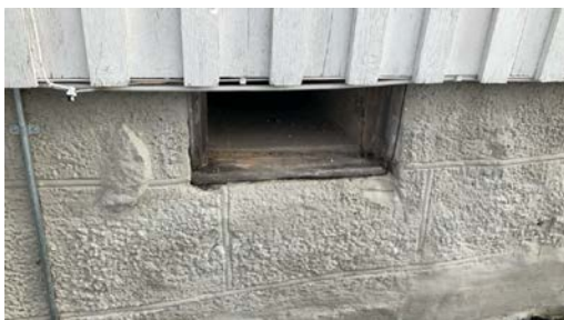
Luke inn til krypkjeller
