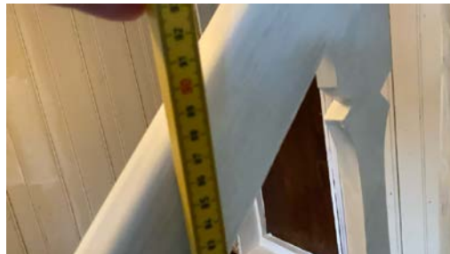
Måling av høyde på rekkverk i trapp.
