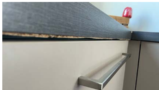
Svelling av benkeplater over oppvaskmaskin
