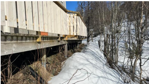
Skjevheter i verandakonstruksjonen
