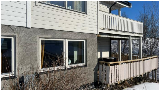
Skjevheter i verandakonstruksjonen
