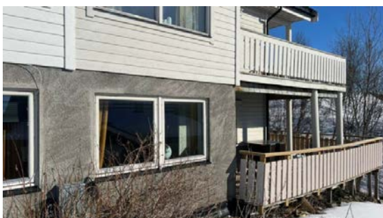
Skjevheter i verandakonstruksjonen
