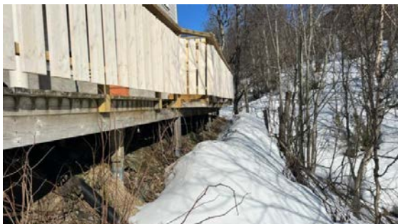
Skjevheter i verandakonstruksjonen
