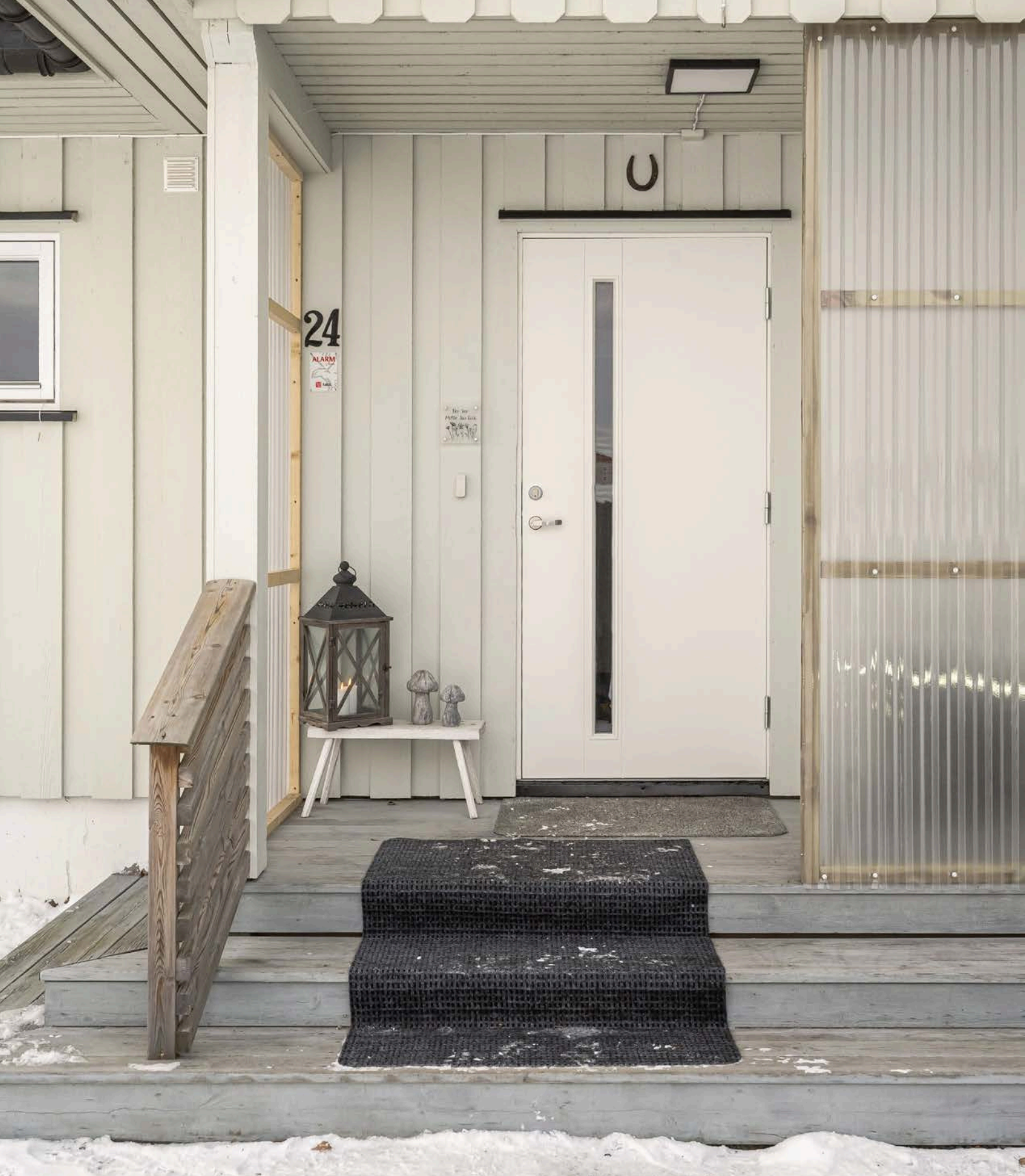
Inngangsparti med takoverbygg og tretrapp med levegger. Entrédøren har isolerglass.
