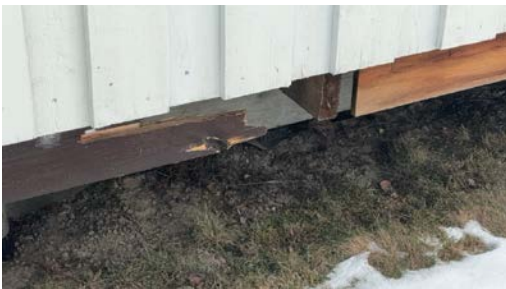
Skade på forkantbord.
