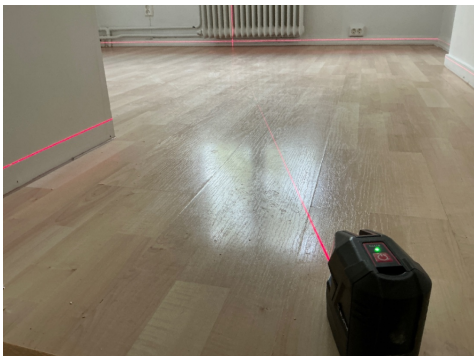
Nivellering soverom, ingen avvik registrert
