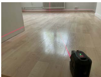
Nivellering soverom, ingen avvik registrert
