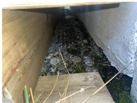
Utsigning av masser under grunnmur
