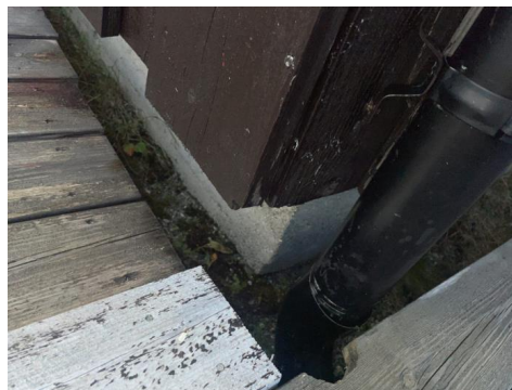
Utsigning av masser under grunnmur
