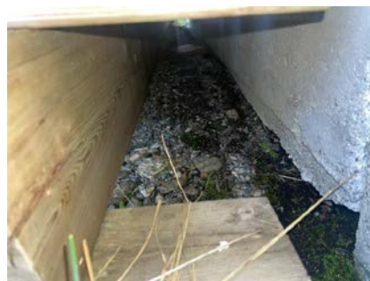
Utsigning av masser under grunnmur
