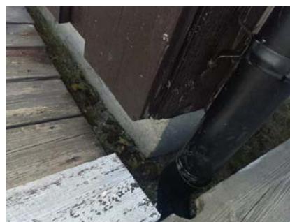
Utsigning av masser under grunnmur
