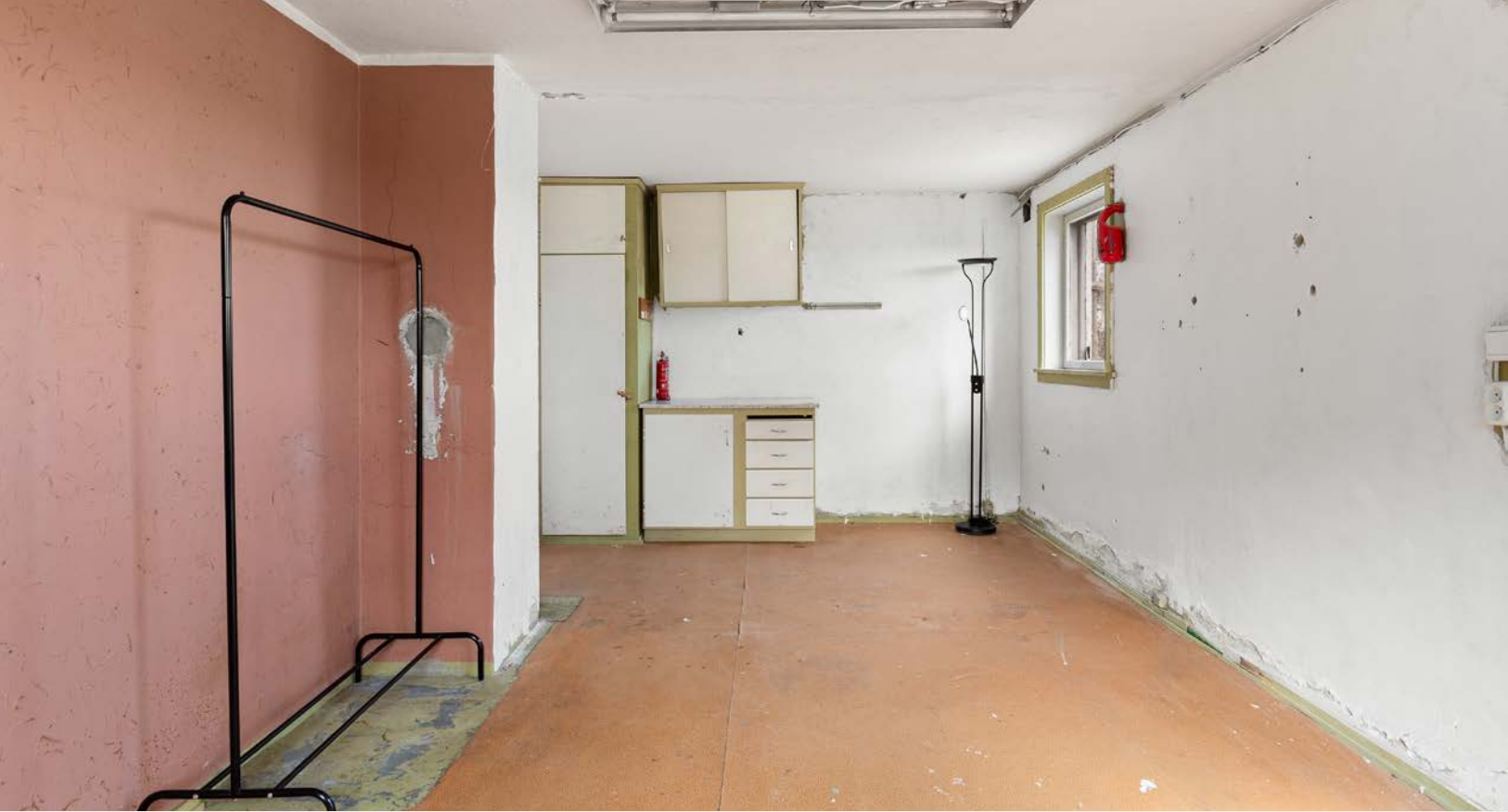
I kjelleren er det 3 uinnrede rom med stort oppgraderingsbehov.
