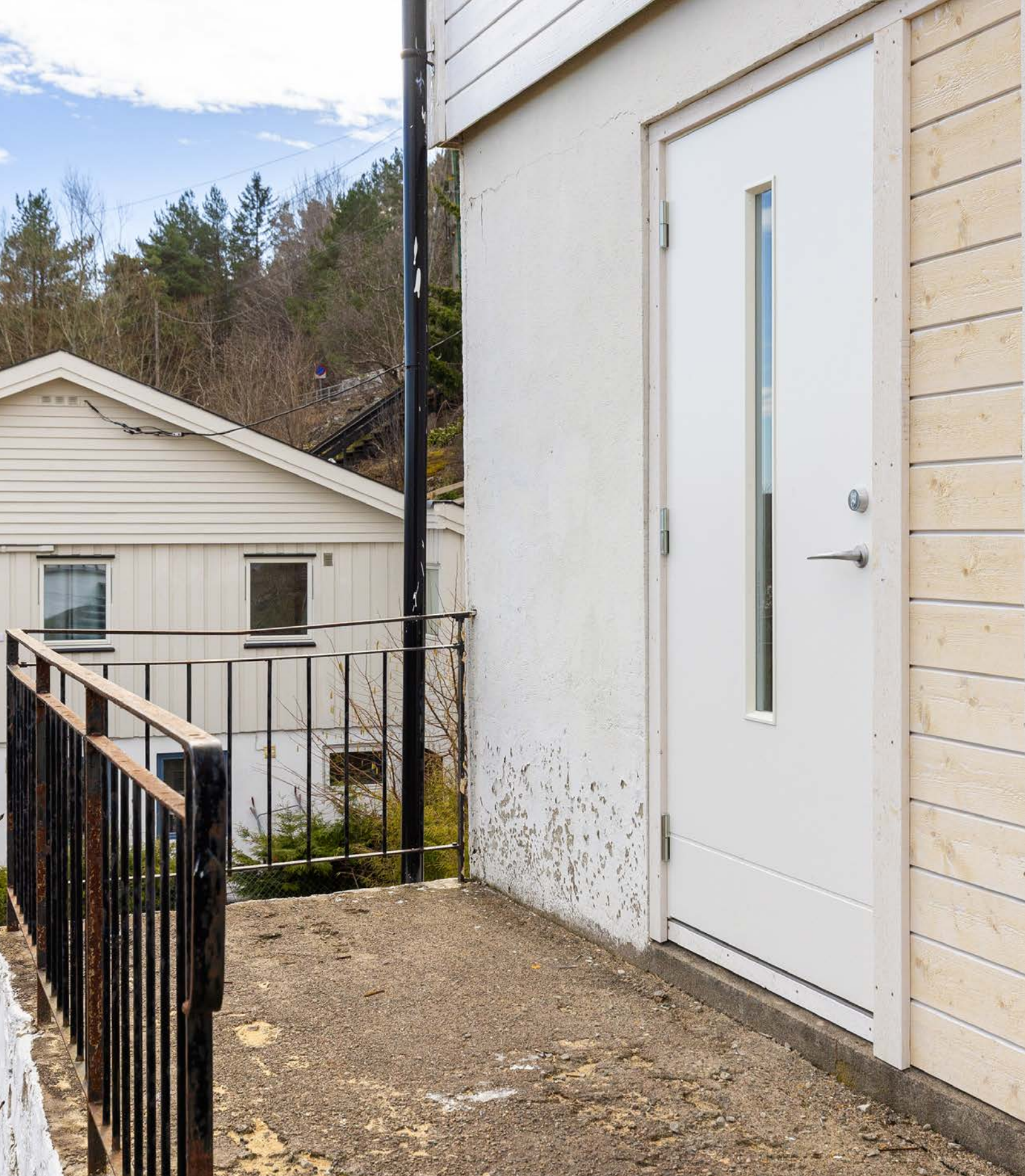
Det er montert ny inngangsdør til kjeller i 2026.
