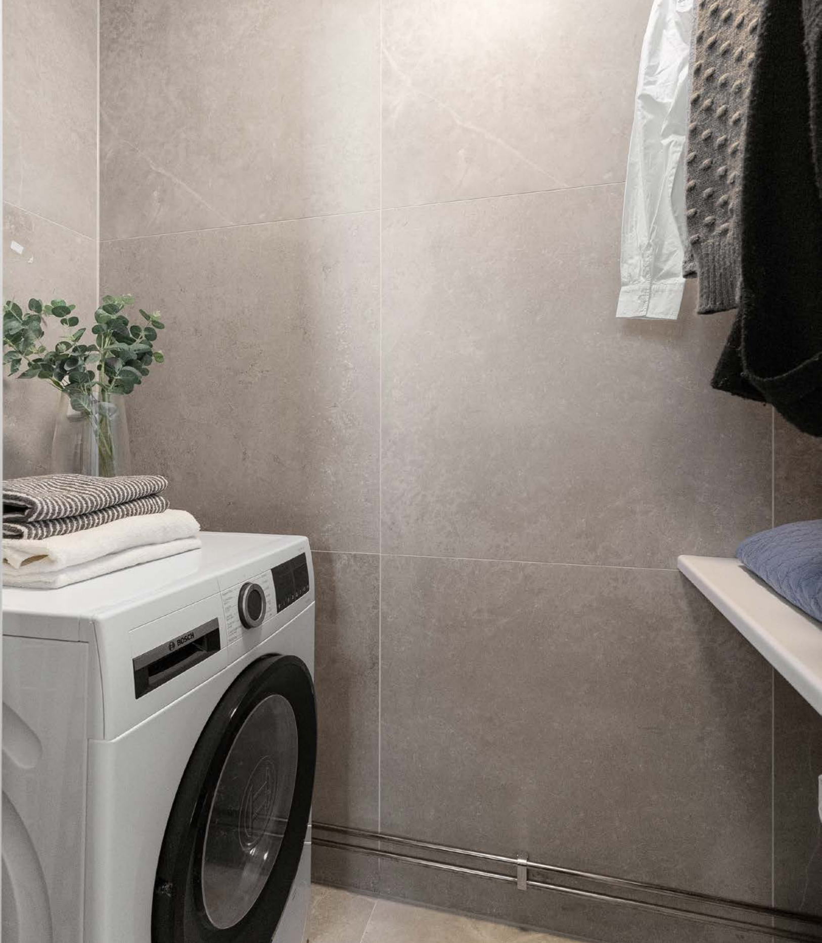
Separat teknisk rom/vaskerom med opplegg for vaskemaskin. Det er her installert en ny bereder i 2023. Berederen er lekkasjesikret, da den er montert i rom med sluk.
