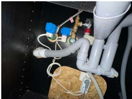
Røropplegg i kjøkkenbenk med Waterguard
