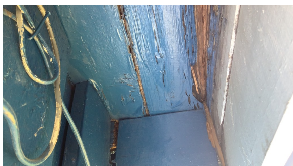
Råteskadet taktro.
