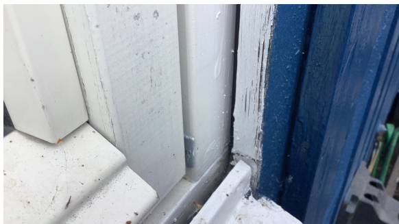
Eksempel på utett beslagsløsning og omramming.
