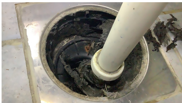
Plastsluk, uten synlig tettesjikt.
