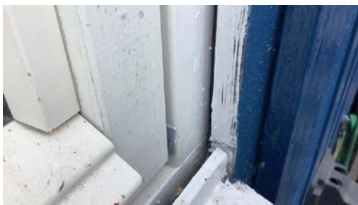
Eksempel på utett beslagsløsning og omramming.
