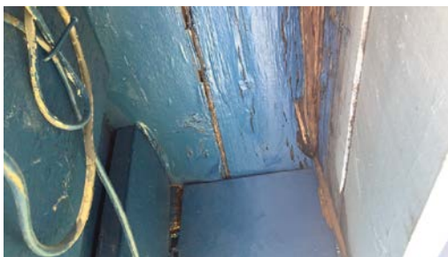
Råteskadet taktro.
