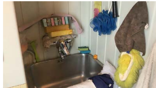
Det er ikke tettesjikt i den definerte våtsonen over vaskekum.
