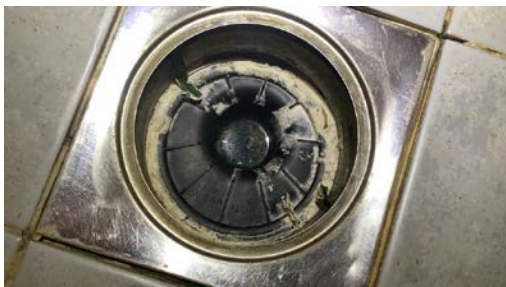
Plastsluk, og det er ikke synlig tettesjikt rundt sluk.
