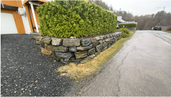
Forstøtningsmur i naturstein.
