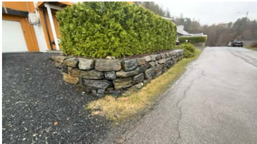
Forstøtningsmur i naturstein.
