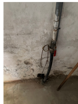
Viser vanninntak i kjeller + stoppekran.
