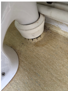
Viser rørgjennomføring i gulvet.
