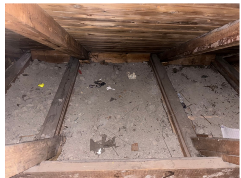
Viser lite ventilasjon i raft
