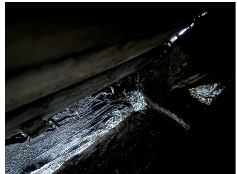
Viser råteskader
