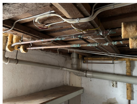
Viser vanninntak i kjeller + stoppekran.
