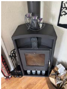
Viser peisovn i 1 etg, mangler brannsikker plate på gulvet
