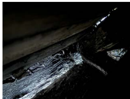
Viser råteskader
