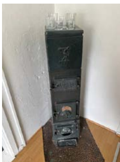
Viser peisovn i 1 etg, mangler brannsikker plate på gulvet
