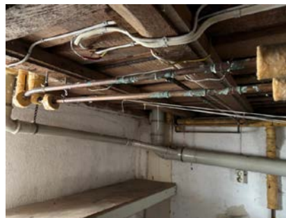
Viser vanninntak i kjeller + stoppekran.
