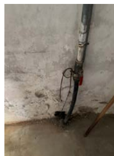
Viser vanninntak i kjeller + stoppekran.
