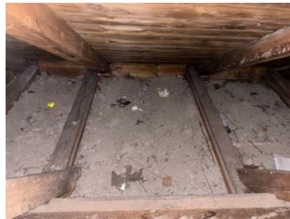
Viser lite ventilasjon i raft
